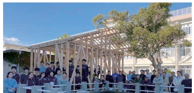
地元工務店・行政と阿南高専生による木造応急仮設住宅(新構法)の建設実験(阿南高専)
