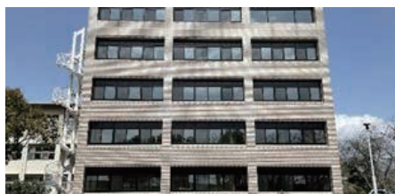
校舎改修（鹿児島高専）
