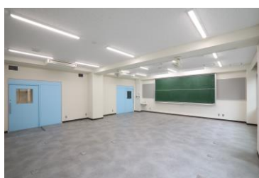
豊田高専：校舎改修
