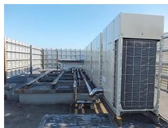
鈴鹿高専：空調設備改修
